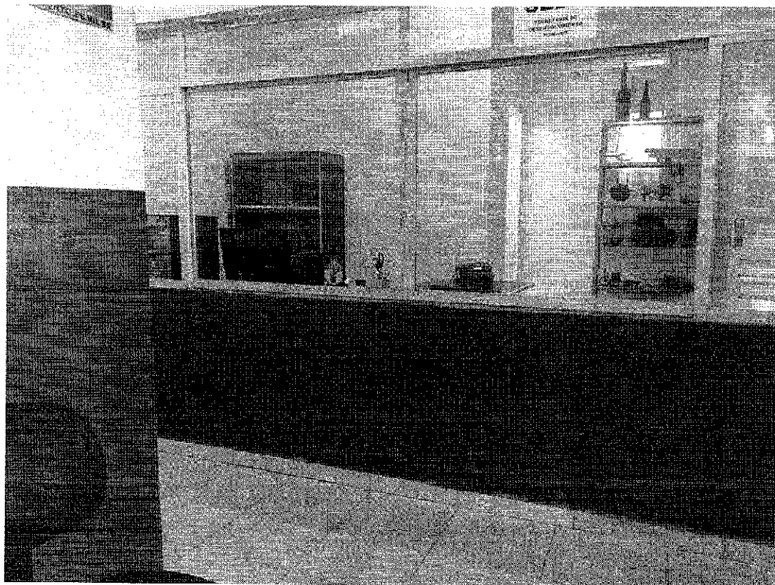
Figura 2 – Janela que será substituída por alvenaria de vedação.
