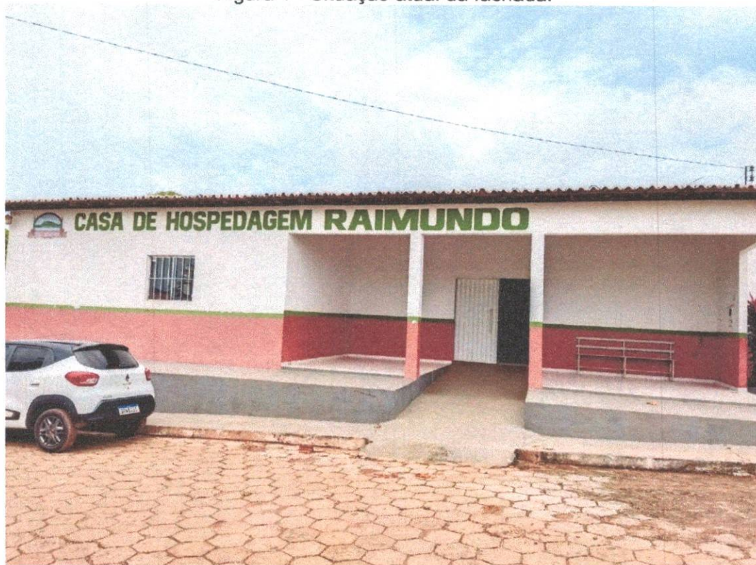
Figura 1 - Situação atual da fachada.
