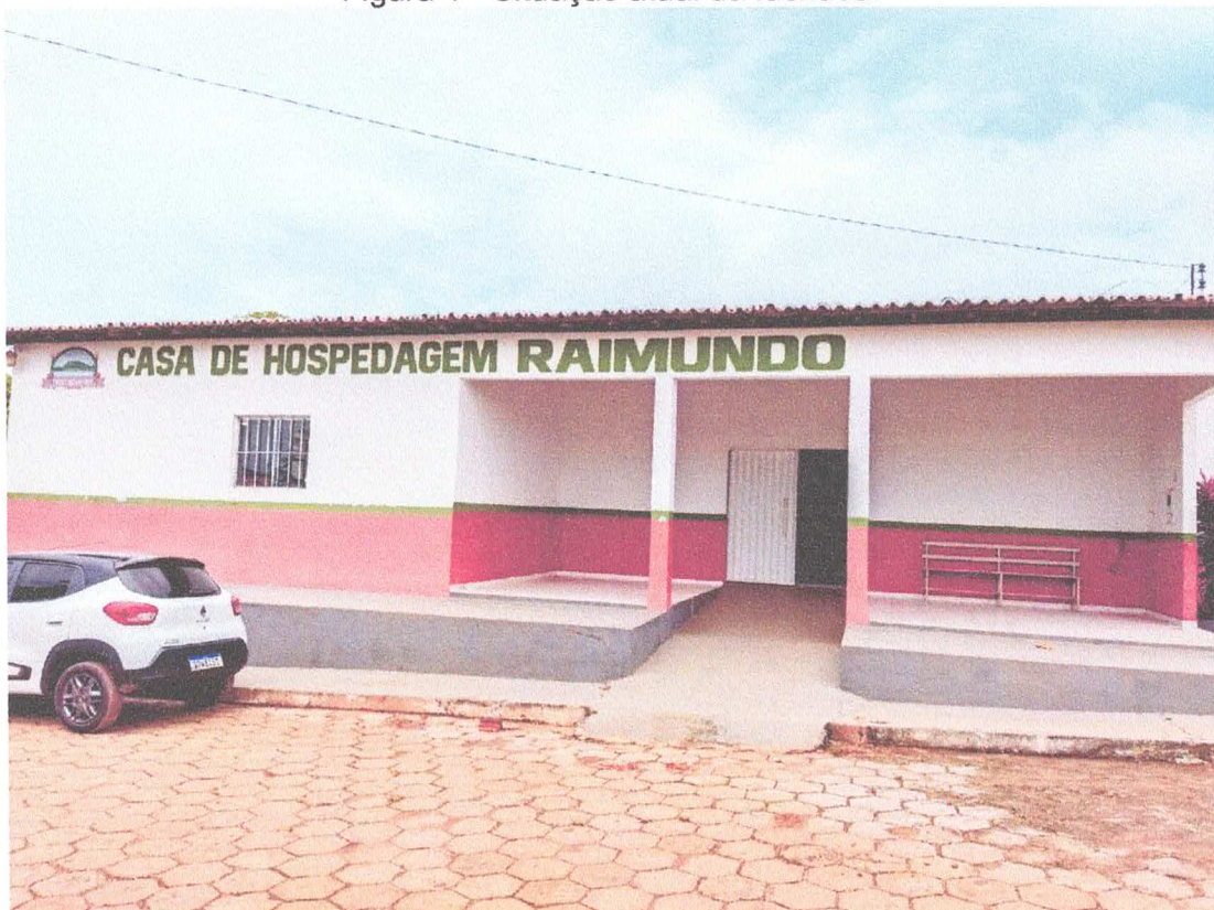
Figura 1 - Situação atual da fachada.
