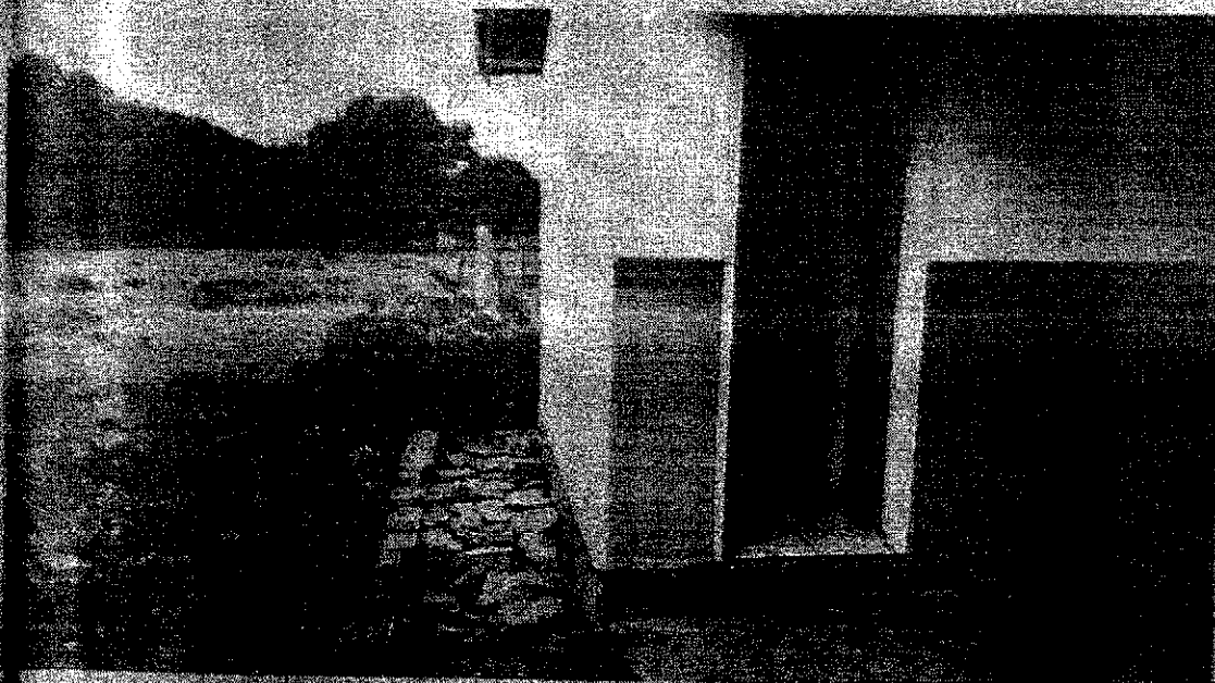
Figura 31 - Estado atual do piso da calçada
